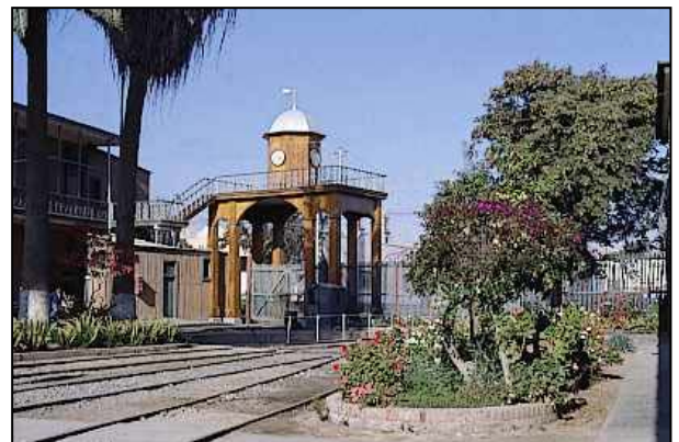
Estación de Tren
